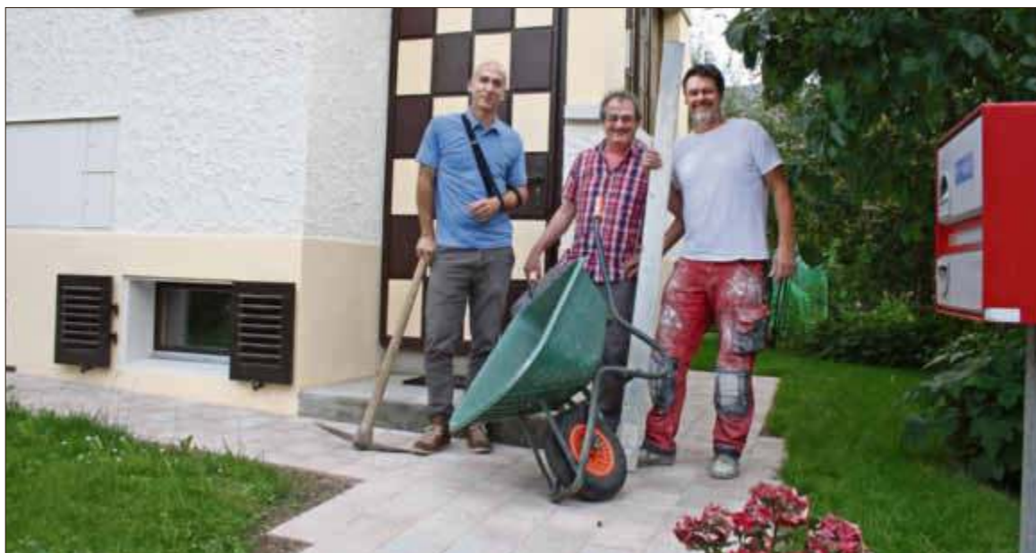
Dank dem Integrationsprogramm Startrampe, bei dem Remo Ramaioli (links) Werkstattleiter ist, hat Hans Zimmermann (Mitte) wieder schöne Wege rund um sein Haus. Rechts Maurer Stefan Ehrensperger. Bild: Till Hiemer
